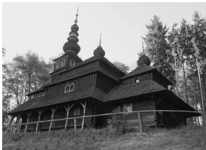
Kostel v Nové Pace
