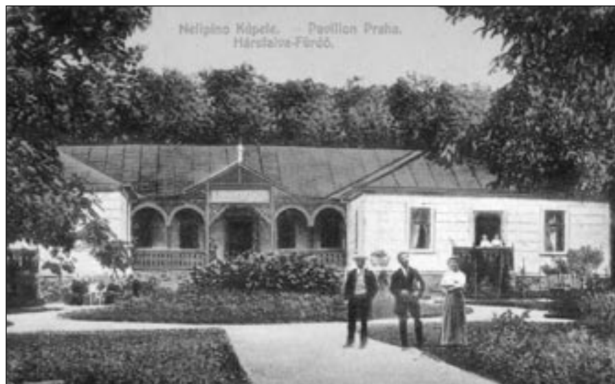
Lázně Nelipino nedaleko Svaljavy – lázeňský pavilon Praha
