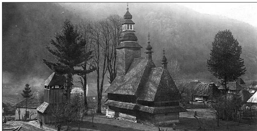
Kostelík se zvonici v Koločavě
