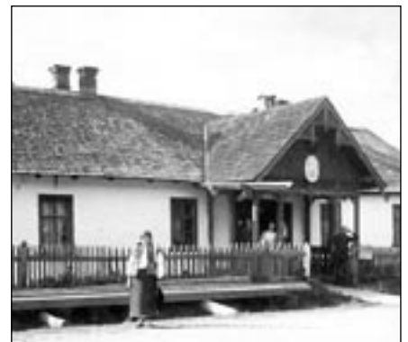
Místní poštovní úřad
