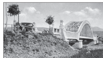
Podkarpatský „Golden Gate“ – most přes řeku Šoporcu u V. Bočkova
